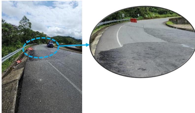
**Ilustración 5. Fotografías asentamiento activo sobre pavimento antiguo y mal estado de mezcla de renivelación (deformaciones y nuevos asentamientos)**
