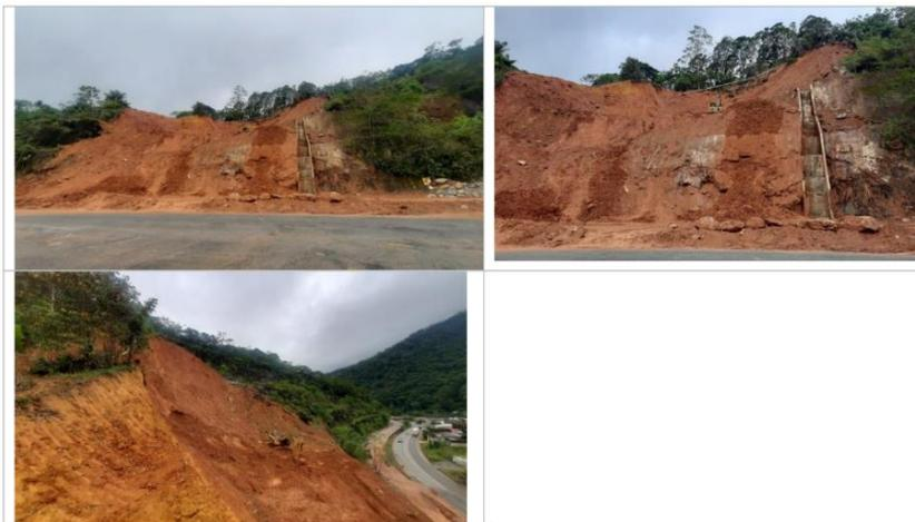
**Ilustración 6. Fotografías despeje de calzada ante emergencia por deslizamiento.**
